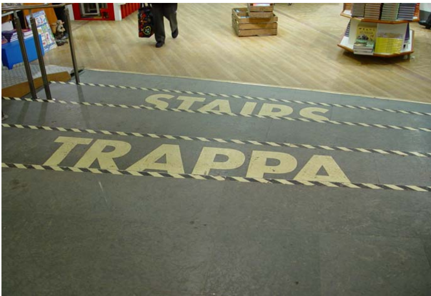
Exempel på lösning. Kontrastmarkering i trappa på varuhus i Stockholm.
